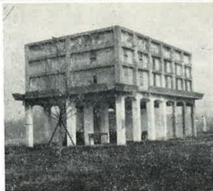
IERI: era un silos per la sabbia sottratta al fiume, ormai in disuso ed abbandonato.
